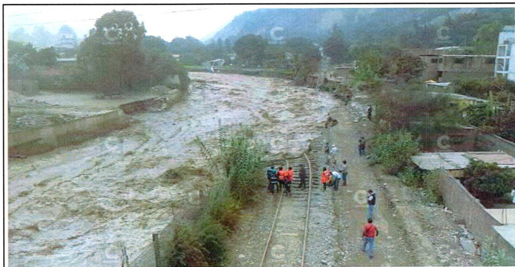
IMAGEN N° 2: EROSIÓN POR SOCAVAMIENTO
